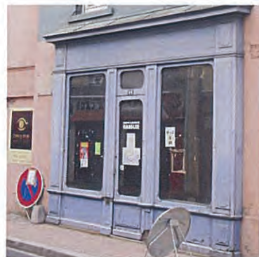
exemple d'applique menuisée
