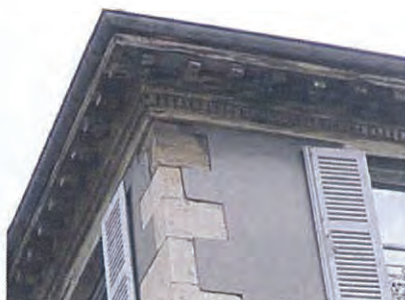
corniche classique en bois formant dépassée de toiture
