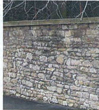
exemple de mur maçonné en pierre à bâtir destiné à être enduit...
