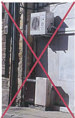
Appareils divers en applique sur la façade
