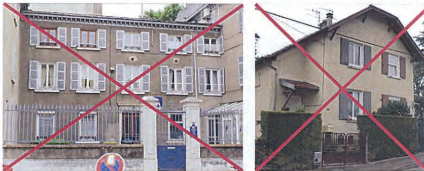
façade aux menuiseries hétérogènes
