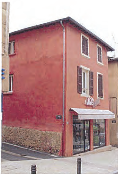
enduit traditionnel à la chaux rue Nationale
