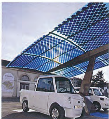
« ombrières » photovoltaïques sur un parking
